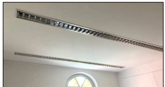
5. SEC/PRI Leitungen verlegen und die Anschlusskabel „Leuchte“ mit „Konverter“ mit Stecker und Kupplung elektrisch verbinden. LED-Konverter auf der 230V Seite fachgerecht anschließen. Geräteeinheit elektrisch prüfen. Lamellenraster wieder in das Gehäuse einfügen. Leuchte in Betrieb nehmen – fertig.
