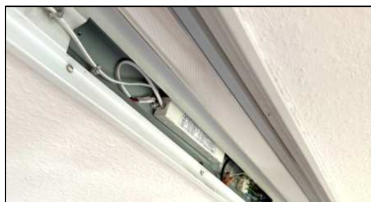
5. SEC/PRI Leitungen verlegen und die Anschlusskabel „Leuchte“ mit „Konverter“ mit Stecker und Kupplung elektrisch verbinden. LED-Konverter auf der 230V Seite fachgerecht anschließen. Geräteeinheit elektrisch prüfen. Lamellenraster wieder in das Gehäuse einfügen. Leuchte in Betrieb nehmen – fertig.
