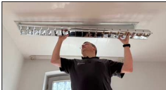
1. Lamellenraster und Leuchtstofflampe ausbauen
