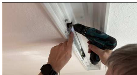
3. Altes EVG/VVG/KVG Betriebsgerät demontieren
