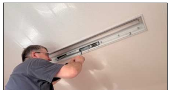
4. Die magnetische EVO UP Sanierungsleuchte in das Gehäuse einlegen und mittig ausrichten. Den LED-Konverter platzieren.
