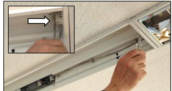
2. Alte Fassung und Kabel aus dem Leuchtengehäuse entfernen. Das Gehäuse bei Bedarf reinigen.
